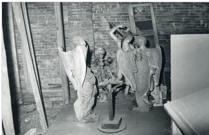
Půdní prostory č.p. 27, před rekonstrukcí
