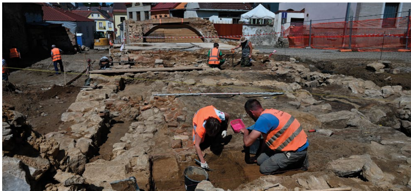
Archeologický výzkum v severní části parcely a základové konstrukce jednotlivých stavebních fází domu.
